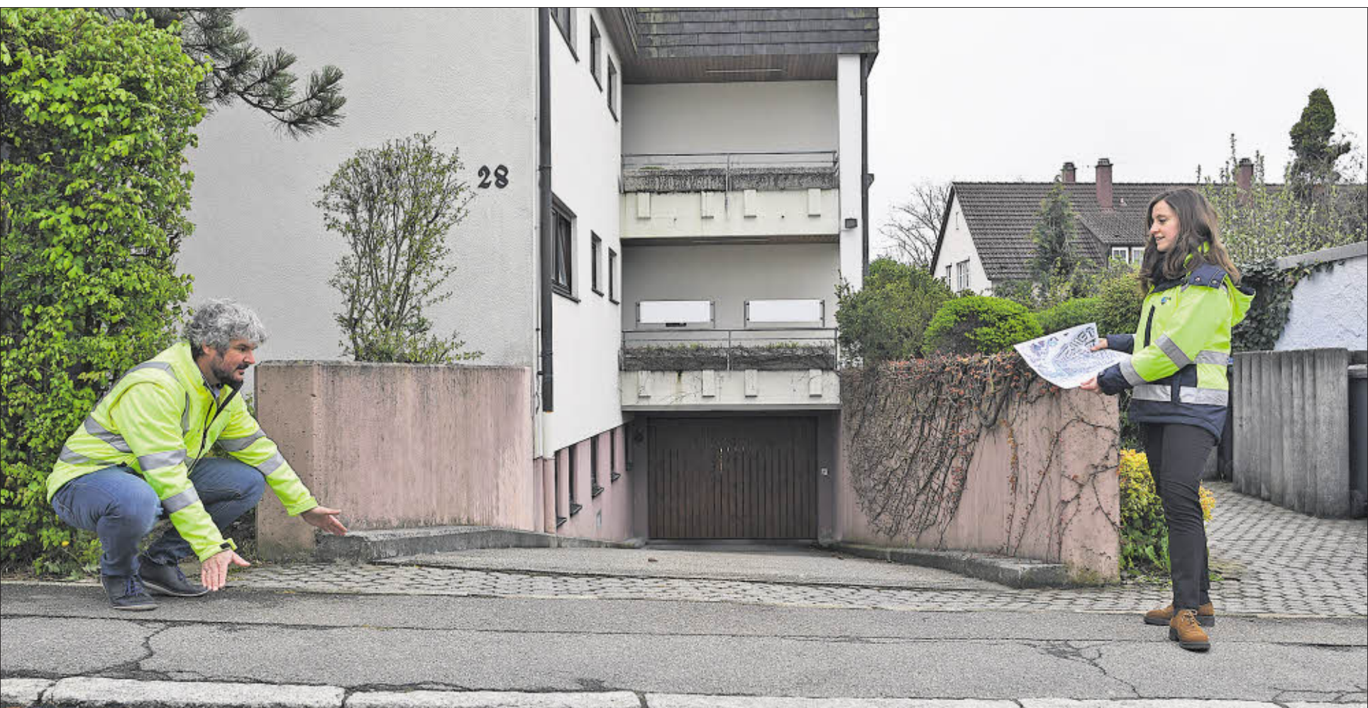
Wo Autos leicht einfahren können, fließt auch Wasser in die Tiefgarage, zeigen Torsten Müller und Sara Meyerlen von der Stadtentwässerung Reutlingen.
